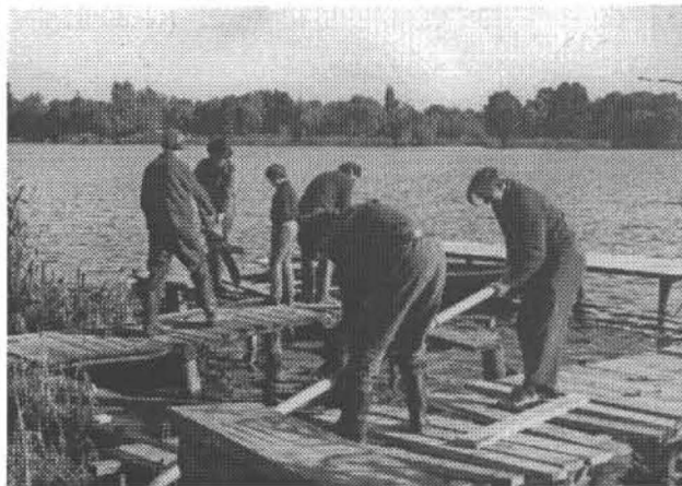
Bau der neuen Steganlage (1972)
