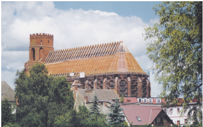
Marienkirche Beeskow, Dachaufbau 1999 (bereitgestellt durch Kurt Krüger)
