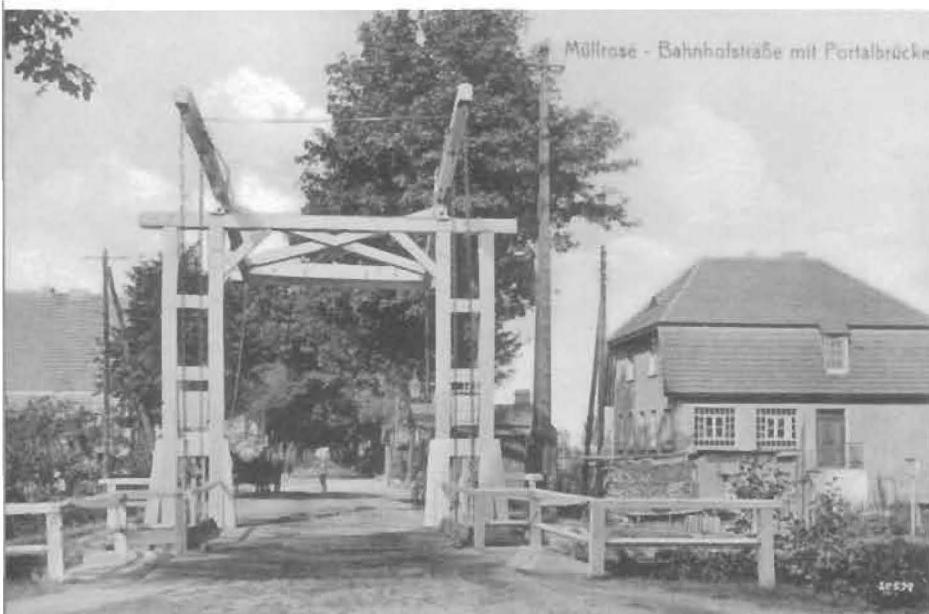
Alte Brücke zwischen Müllrose und Kaisermühl
